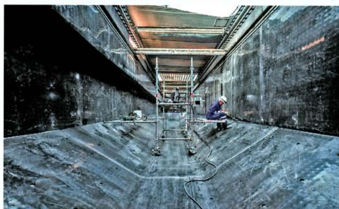
Bild 2 Beckenauskleidung mit Schweißnaht
