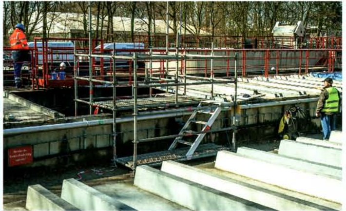
Bild 4 Die Klärbecken während der Auskleidungs-Arbeiten
