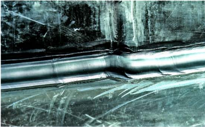
Bild 3 Extrusionsschweißnaht am Becken
